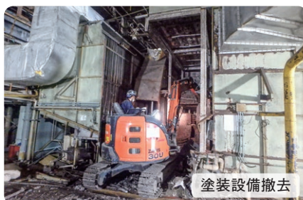
塗装設備撤去
