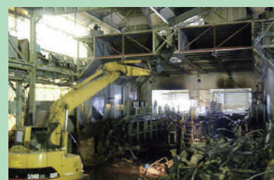
火気のない独自工法で、塗装設備も安全に解体
